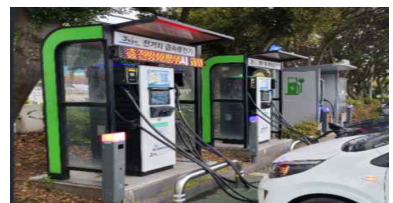
《 전기차 충전기 설치 》
